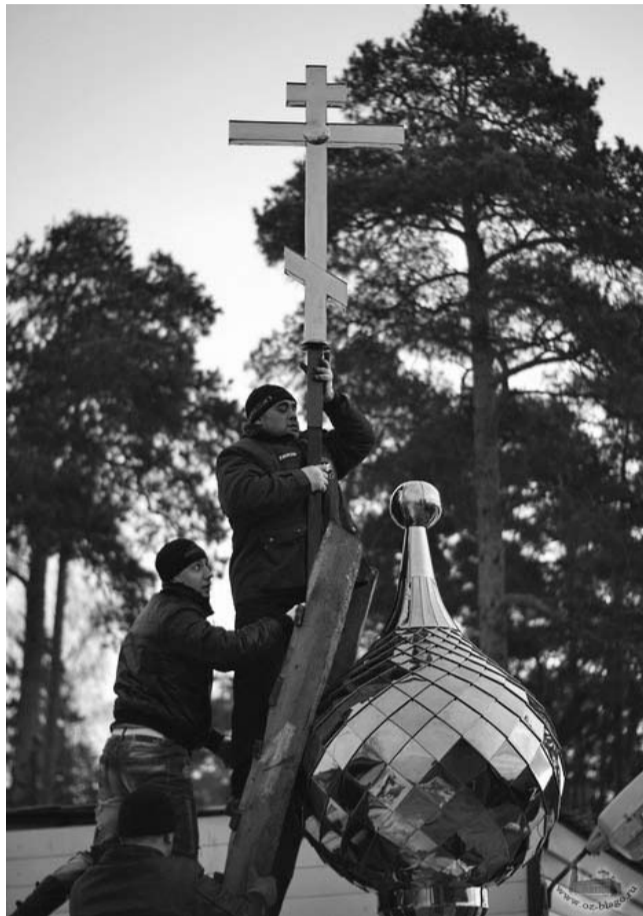
Последняя новость со строительства храмового комплекса: 29 декабря состоялся подъём купола на храм Петра и Февронии.
